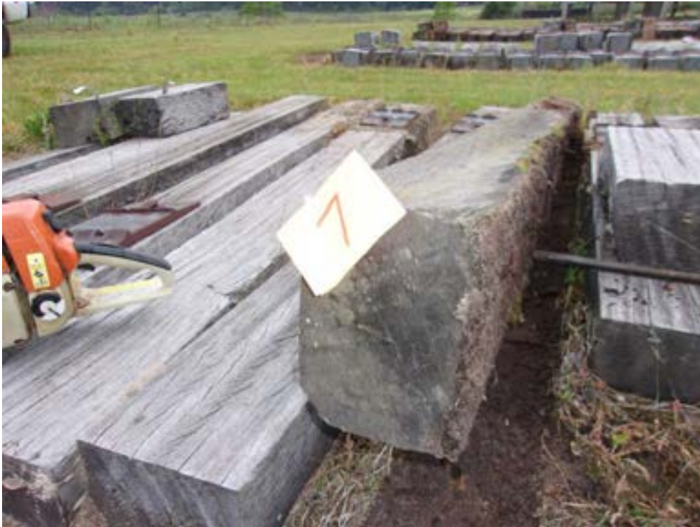
A65 - Tie #7 (Turada) with decay.
